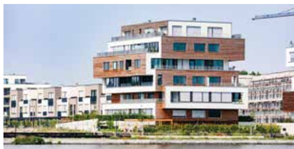
Holz-Hybrid-Bauweise im Developmentprojekt „52 Grad Nord“ in Berlin
