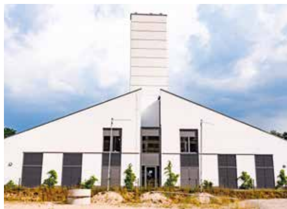
Blockheizkraftwerk im Developmentprojekt „52 Grad Nord“ in Berlin
